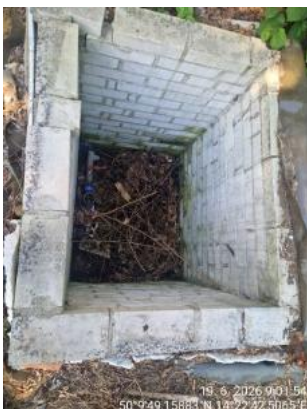
vodovodní šachta
