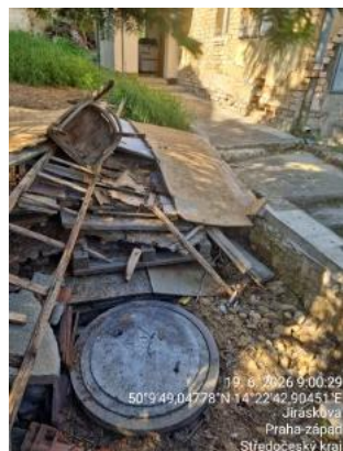
napojení na kanalizaci
