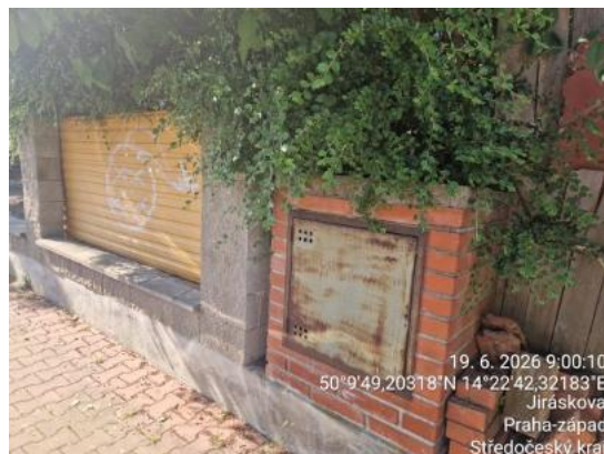
pilíř pro napojení plynu
