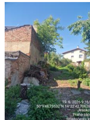
sousední stavba a chybějící plot
