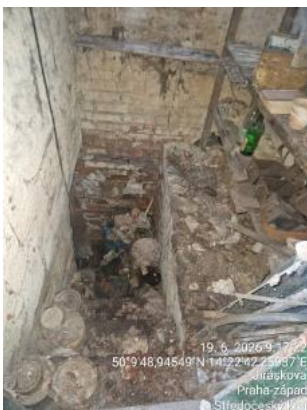
přístup do sklepa
